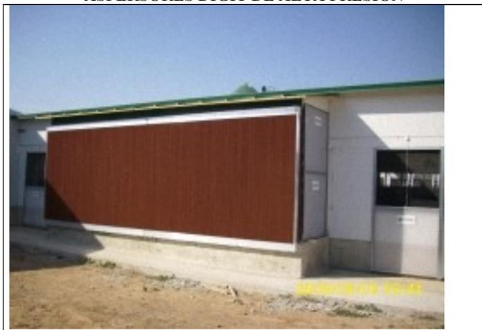
**COOLING PARA VENTILACION TIPO TUNEL**
