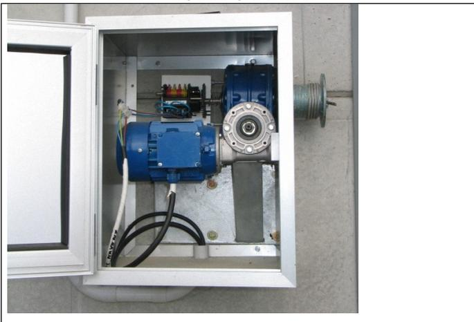
**DETALLE DEL INTERIOR DEL ARMARIO CON EL MOTORREDUCTOR Y FINAL DE CARRERA**
